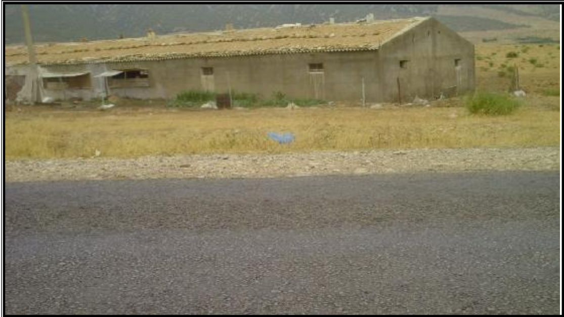
Figure 4: Bâtiment situé à proximité de la route nationale (poulets exposés au stress sonore) (Khenenou, 2012).
