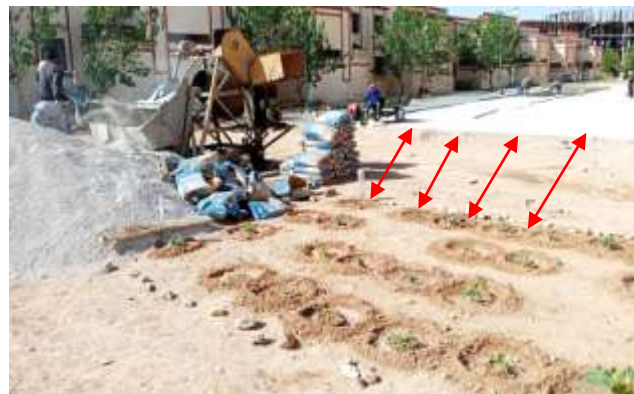
Figure 8 : Travaux d'aménagement de l'aire de jeux
