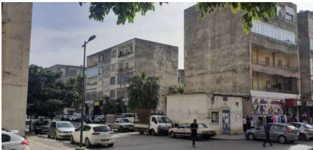
Figure N°09 : Implantation d'un poste de transformateur sur la paroi d'angle d'un immeuble du quartier sghir
