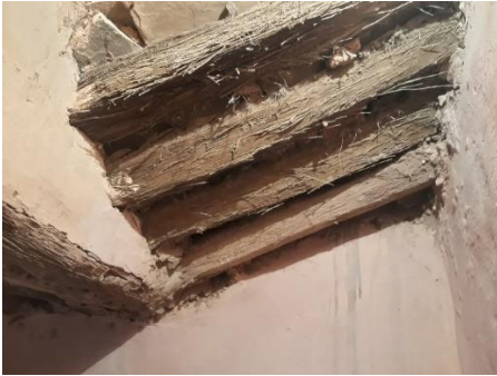
Figure16 : disposition successive du zekkour (par auteurs).
