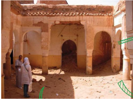
Figure 3: L'état initial de l'habitation (Barkani A, 2008-2009)
