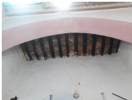
Figure 13 : plancher en bois rouge au lieu de troncs de palmier (Auteurs).
