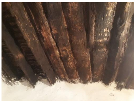
Figure 12 : plancher en roseau de laurier rose (defla) (Auteurs).
