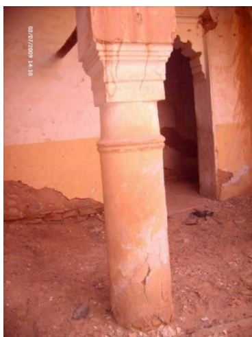
Figure23 : état initial de colonne dépourvu de décor (Barkani A, 2008-2009).
