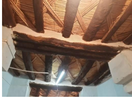
Figure15 : utilisation de roseau au lieu de roseau de laurier rose (Auteurs).
