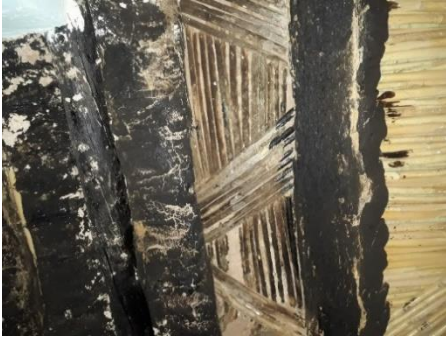
Figure14 : les troncs de palmiers comme poutre (Auteurs).
